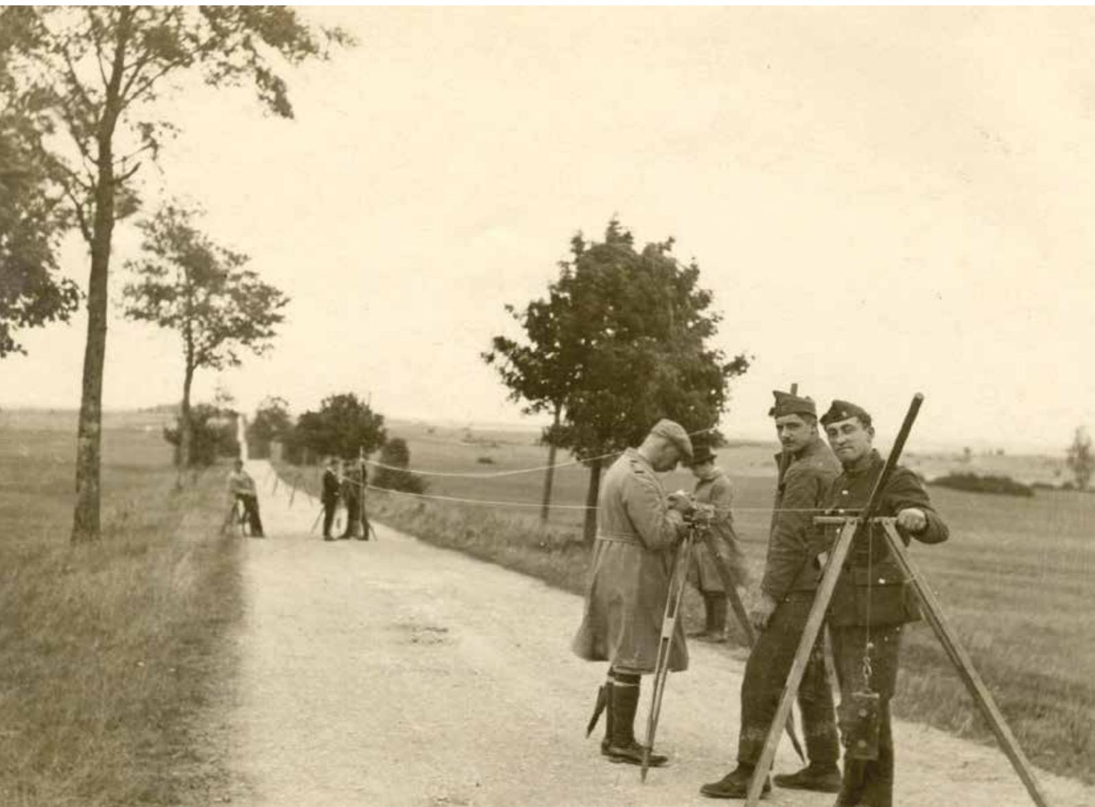
*Détermination de la base entre Habay et Etalle (B) dans le cadre de l'établissement du réseau de la triangulation du Grand-Duché de Luxembourg (1927).*
